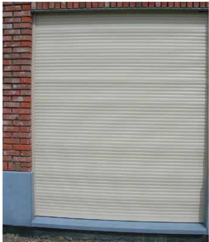
Bild 4: Welligkeit von Rollladenpanzern
